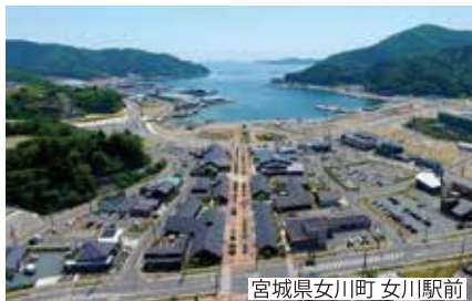
宮城県女川町 女川駅前
