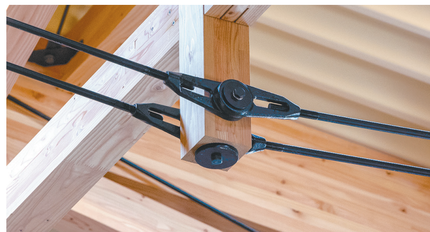
トラス構築に使用するオリジナル金物「ATA-truss」
